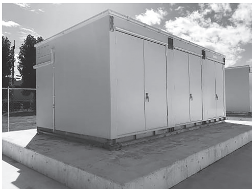
図6 瞬低補償装置(正面)
