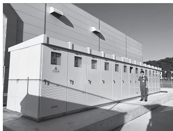
図11 高圧分岐盤
